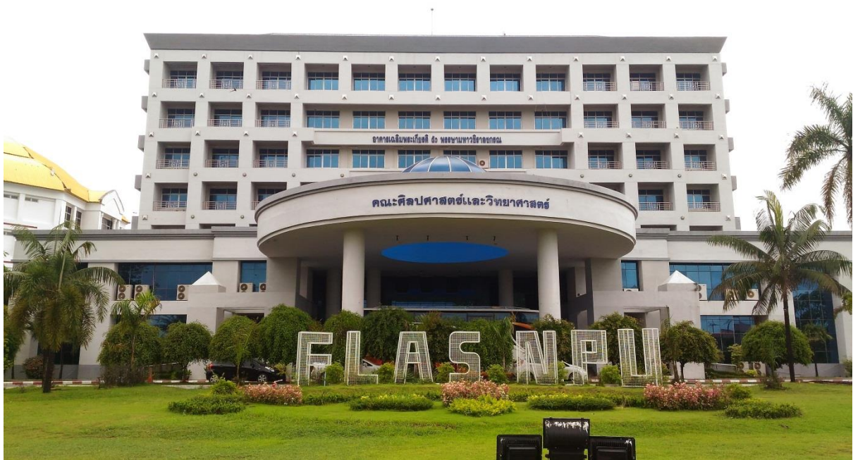
หลังเสร็จโครงการ Green Location FLAS NPU
