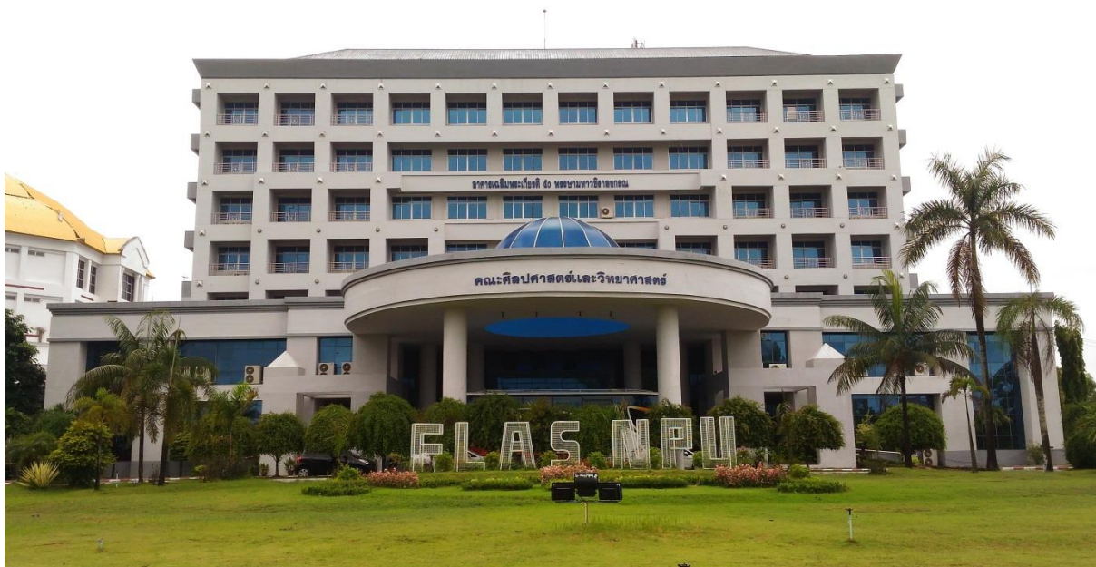
หลังเสร็จโครงการ Green Location FLAS NPU
